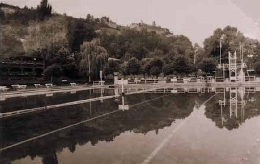
Bild 16: Schwimmbecken von 1934 mit Sprungturm
