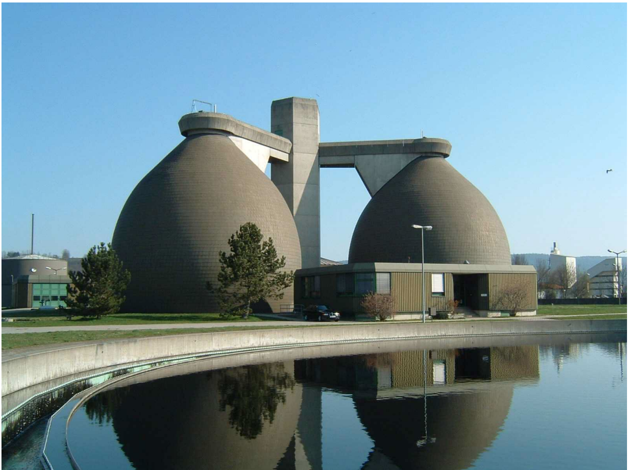
Das Zentralgebäude der Kläranlage Kulmbach mit Faulbehälter im Hintergrund
